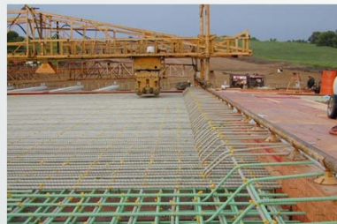
53 rd Ave. Bridge, IA
