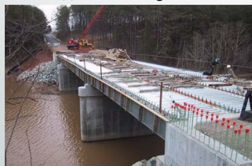
Franklin Co. Bridge, VA
